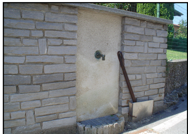
Figura 5.22: Foto pompa dell'acqua
