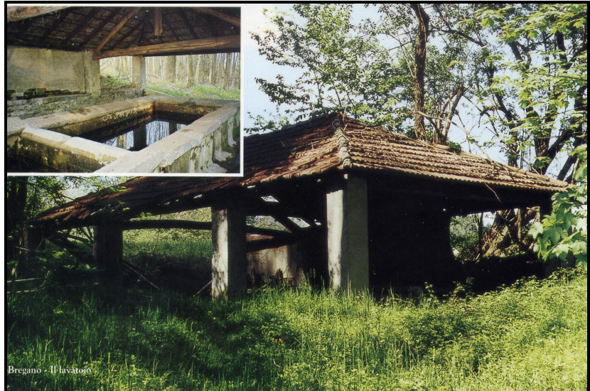
Figura 5.26: Foto resti del lavatoio
